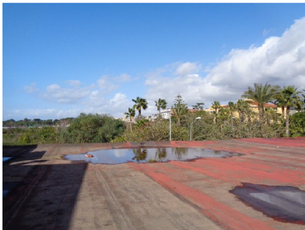
Lastrico solare: particolare della presenza di pozze di ristagno d'acqua piovana
